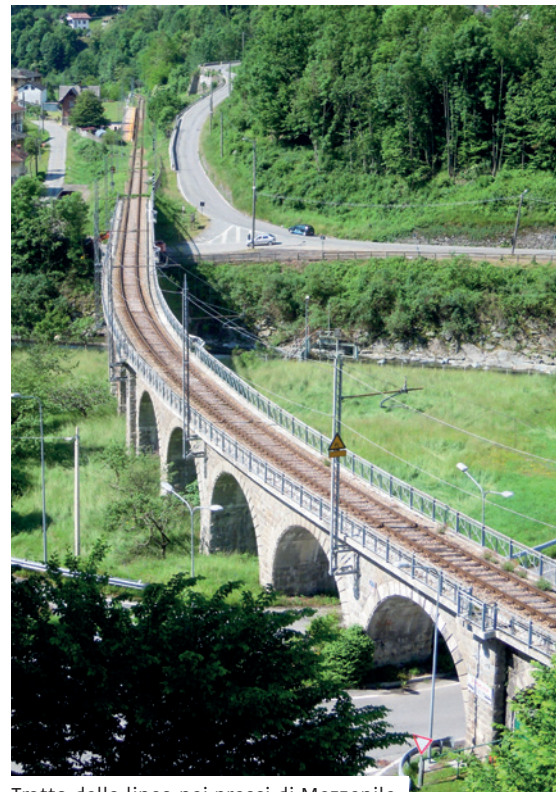
Tratto della linea nei pressi di Mezzenile.
